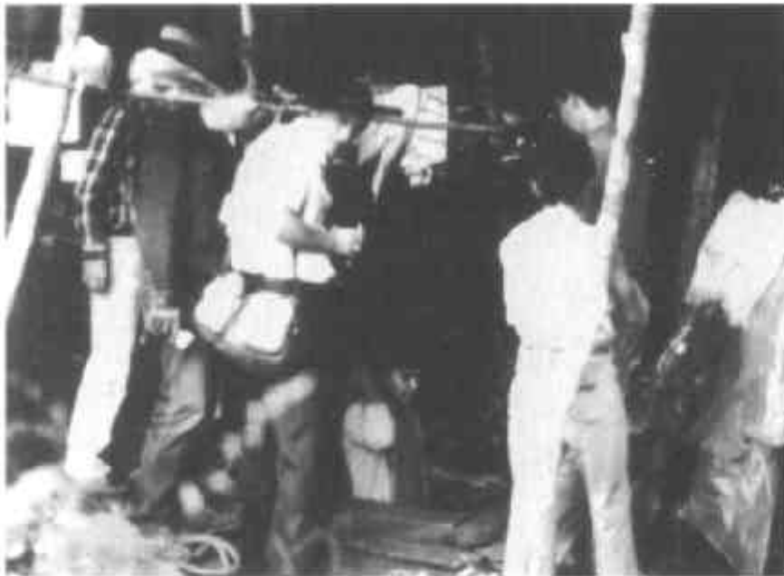
Momento del ingreso al túnel.
